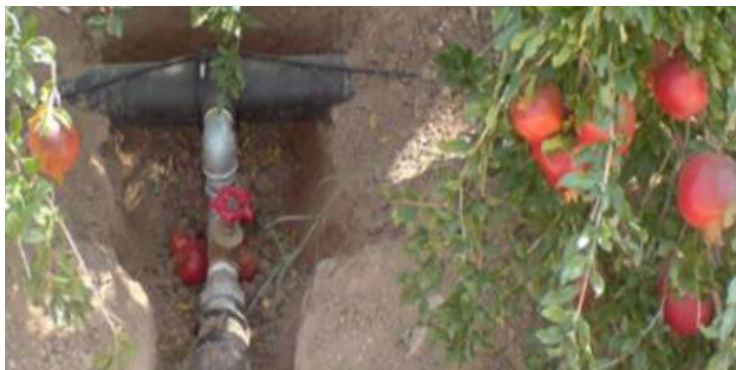
تصویر ۳-۵- انتقال آب با لوله از استخر ذخیره‌ی آب
