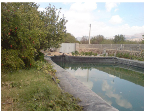
تصویر ۵-۲- احداث استخر ذخیره‌ی آب در باغ‌های قدیمی
